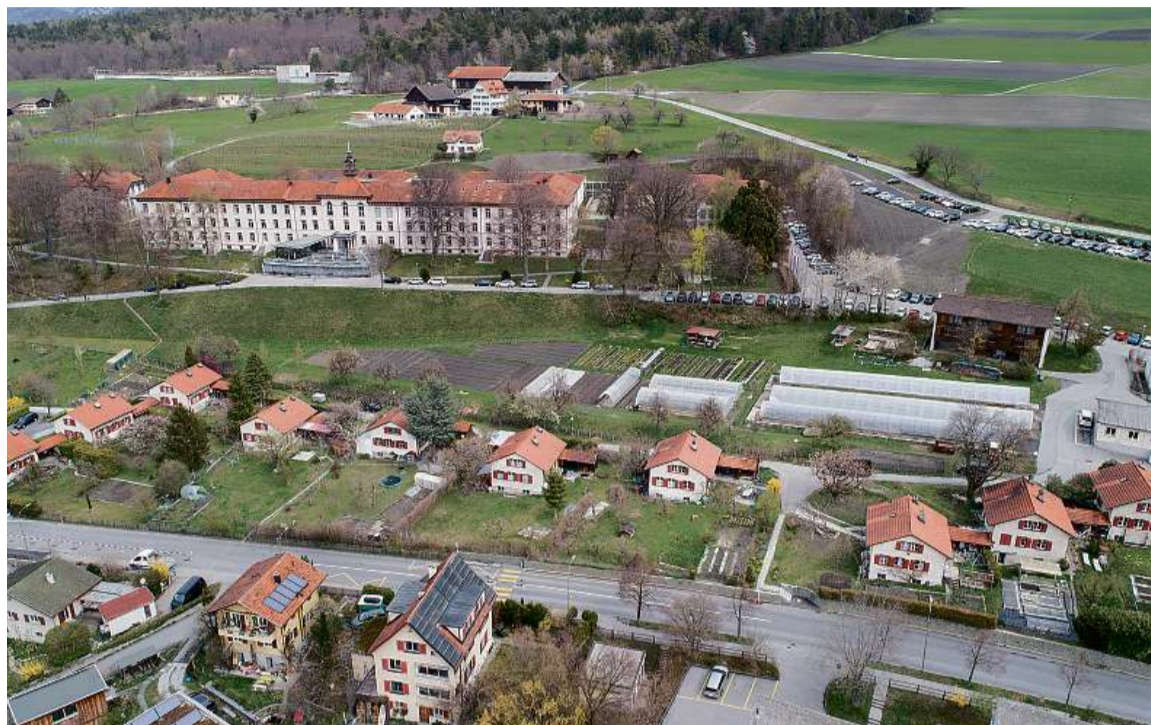
Ein Stück Geschichte verschwindet: Die Siedlung Waldhaus in Chur muss einer neuen Überbauung weichen.
