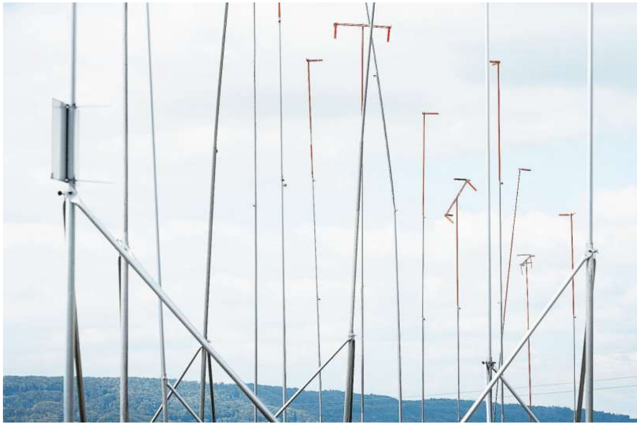
Wo heute Bauprofile in die Luft ragen, mussten häufig erst noch Gebäude abgerissen werden.
